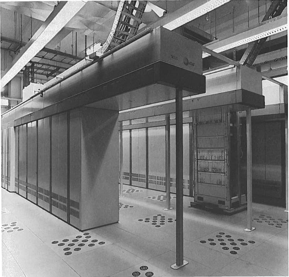
▲ Foto 6 5ESS-centrale, een volledig digitaal systeem met dubbel uitgevoerde processor.
